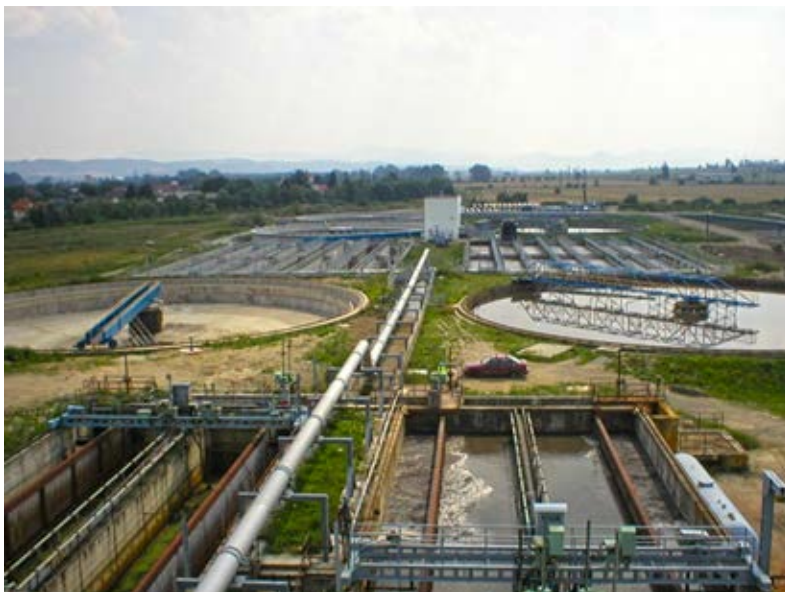
Obr. 1 Lapače piesku a usadzovacie nádrže
