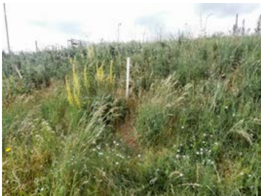
Obr. 11 Násyp vonkajšej komunikácie okolo usadzovacích a dosadzovacích nádrží s výskytom trávnych suchomilných porastov (TBT 9)
